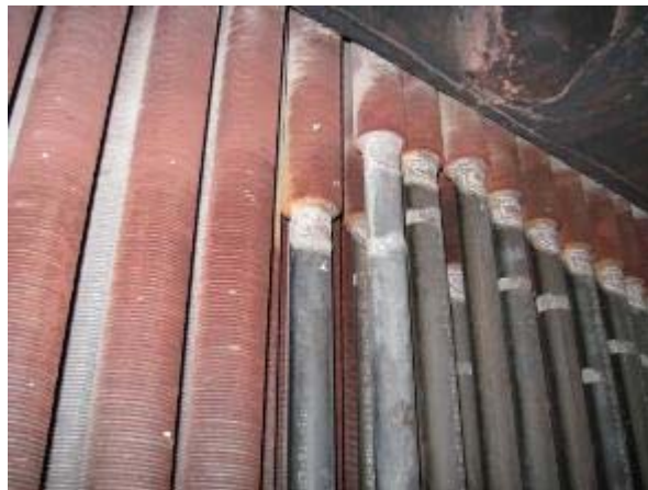
Photo 3.25.3 HRSG 1 Tube Repairs
